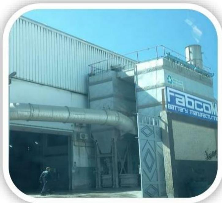
**Figure 32 : Filtre à manche pour le traitement des fumées.**
